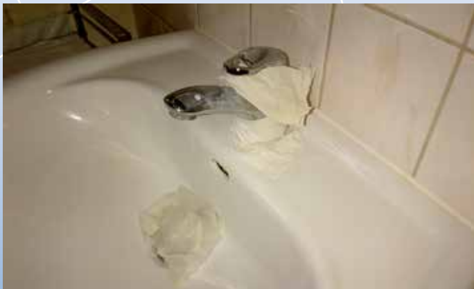
Einsatz von Essig-Essenz mit der Absicht, Kalk zu entfernen. Bild rechts: Der Einsatz von Scheuerschwämmen zerstört die Armatur zusätzlich und irreversibel
